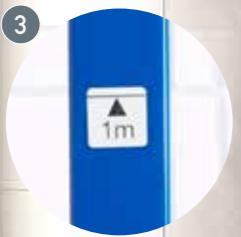
Installert 1 m over ferdig gulv gir det en sitthøyde på 410-430 mm, avhengig av toalettmodellen. Kan ved installering justeres opp til 610-630 mm.
