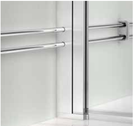
PROFIILISSA ON TILA REI'ILLE, PINTAVESIPUTKIEN LÄPIVIENTIÄ VARTEN.
