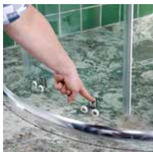
VIPP-IN OCH JUSTERBAR GOLVPROFIL MED "AVRINNINGSHÅL" PÅ SKJUTDÖRRAR.
